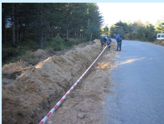
Ramal de abastecimento de água em SECERIGO
