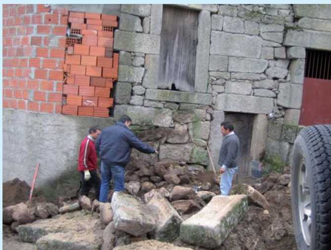
Alargamento de rua e reconstrução de escadas em NOGUEIRA
