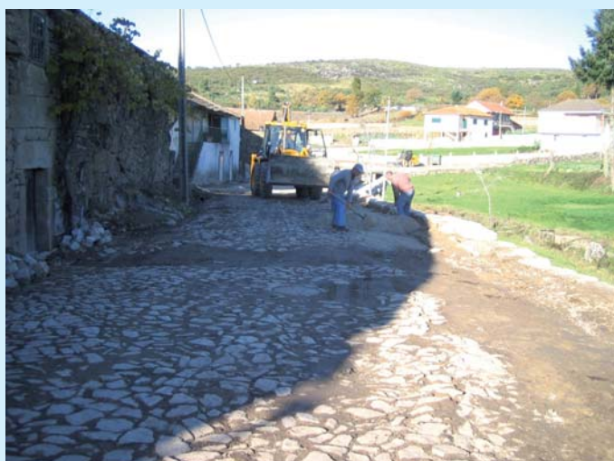
Construção de um muro de suporte e repavimentação em VIVEIRO
