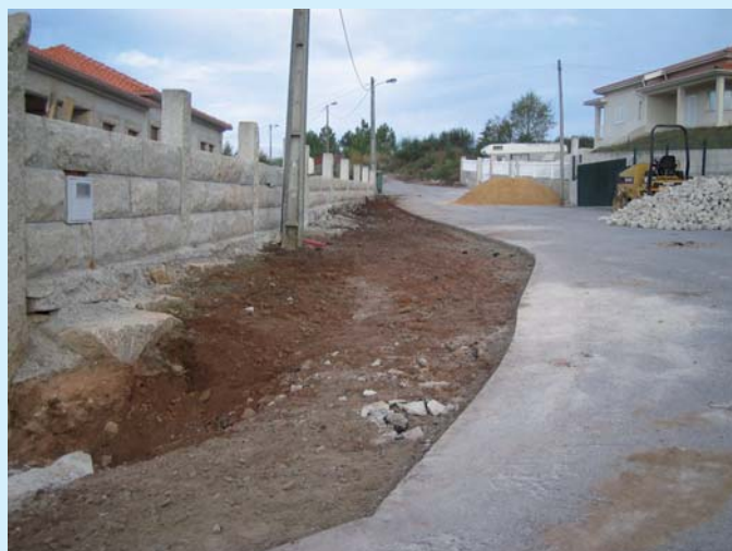
Alargamento de rua e pavimentação em BEÇA
