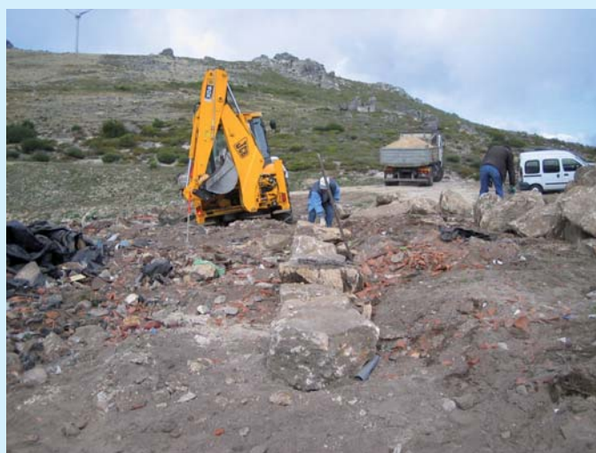
Construção de estrutura para colocação de caixa metálica em ATILHÓ
