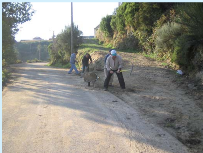
Prolongamento da rede de saneamento em ALTURAS DO BARROSO
