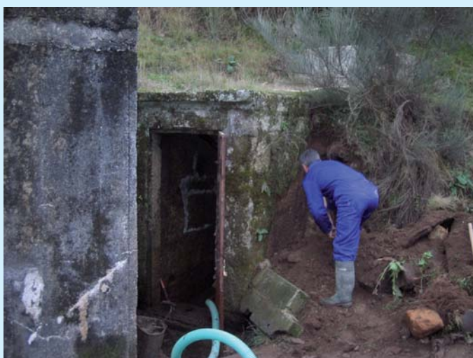
Beneficiação de depósito de água em ALTURAS DO BARROSO
