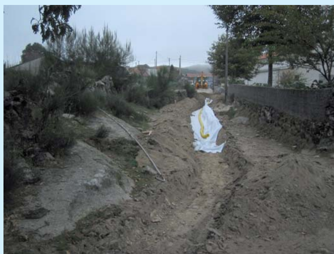
Drenagem de águas num caminho em ATILHÓ
