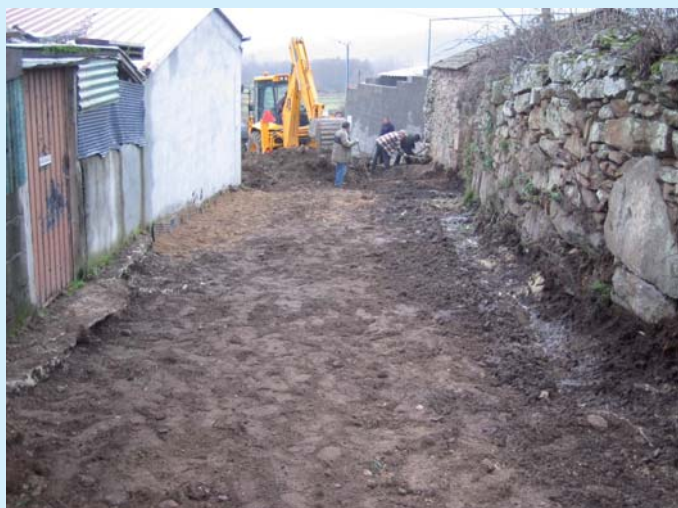
Pavimentação de arruamento na GRANJA
