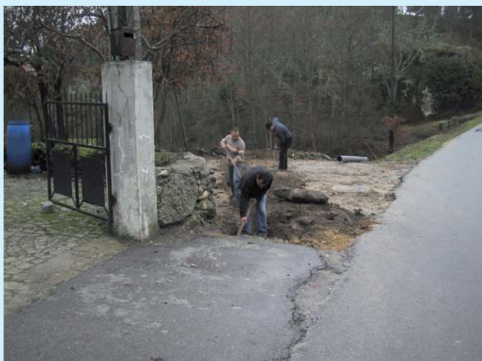
Prolongamento da rede de saneamento em SAPIÕES
