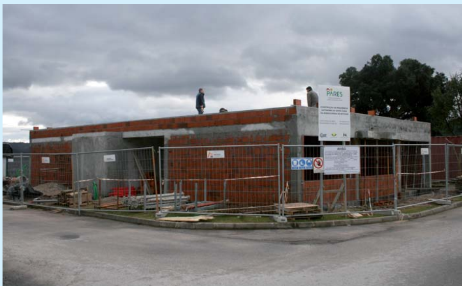
OBRAS DE CONSTRUÇÃO da Residência Autónoma para Deficientes
