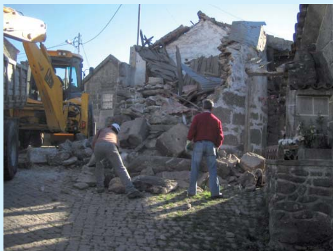
Demolição de uma casa para alargamento do largo em BOSTOFRIO
