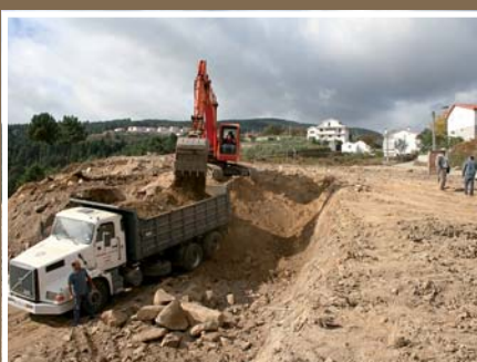
Desaterro para construção de habitações a custos controlados em BOTICAS
