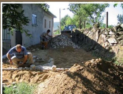
Pavimentação de arruamento em SAPIÃOS
