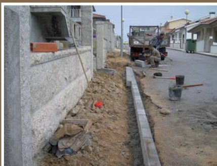
Construção de passeio no Bairro da Noruega em BOTICAS
