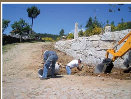
Alargamento e Pavimentação em CARVALHO
