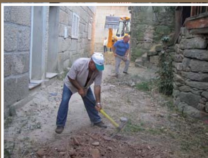
Pavimentação de arruamento em SAPELOS
