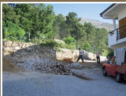
Pavimentação em SAPIÕES
