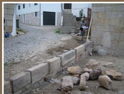
Pavimentação e construção de muro na GRANJA
