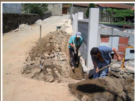
Alargamento e Pavimentação em VIVEIRO
