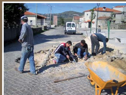
Repavimentação em ATILHÓ
