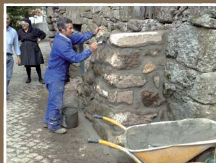
Construção de escadas em SEIRRÃOS
