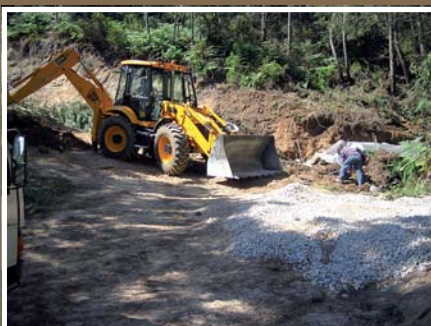
Reconstrução de uma captação de água
