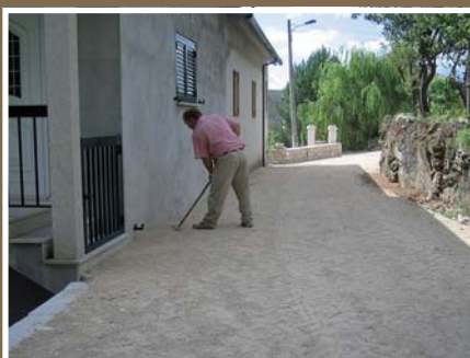
Pavimentação de arruamento em SAPIÃOS
