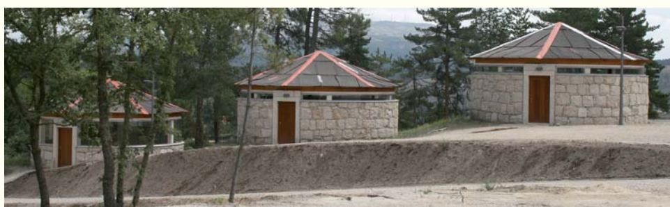
ESTRUTURAS DE APOIO do Parque Aventura
