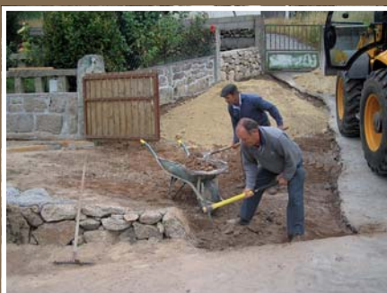
Pavimentação em BEÇA
