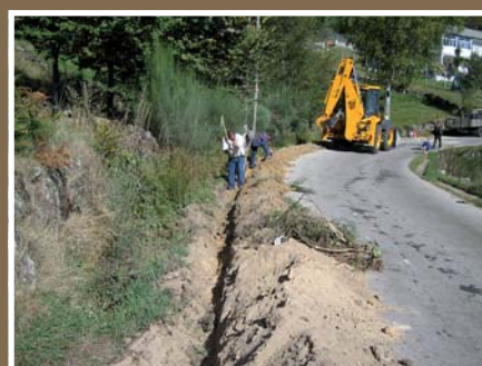
Reforço do abastecimento de água em ALTURAS DO BARROSO
