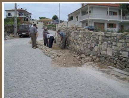
Alargamento e Pavimentação em PINHO
