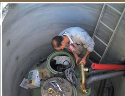
Instalação de estação elevatória de águas residuais em SAPELOS
