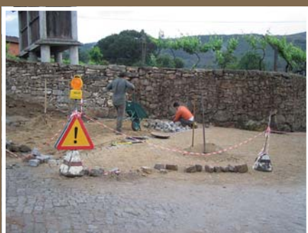
Pavimentação em SANGUNHEDO
