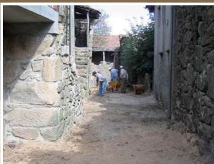
Pavimentação de arruamento em SAPELOS
