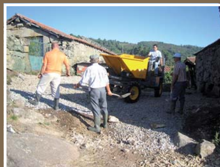
Pavimentação em SEIRRÃOS
