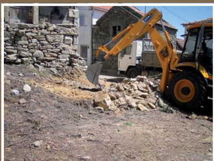
Pavimentação em VILARINHO DA MÓ
