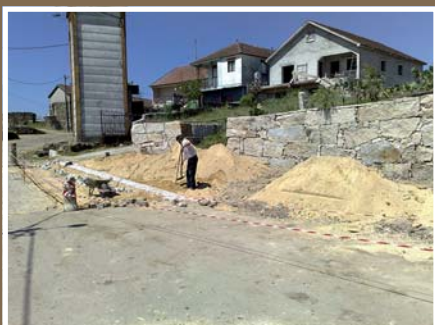
Alargamento e Pavimentação em VIVEIRO
