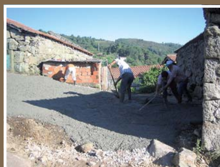
Pavimentação em SEIRRÃOS
