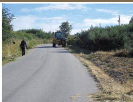
Limpeza de bermas nas estradas
