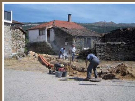
Ligação de saneamento em SANGUNHEDO
