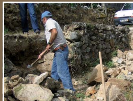
Reconstrução de muro em QUINTAS
