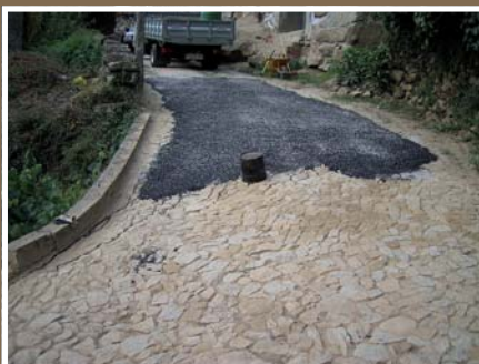
Repavimentação em SOBRADELO
