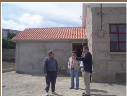
Nova Sede da Junta de Freguesia em ALTURAS DO BARROSO
