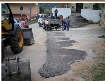
Repavimentação em SOBRADELO
