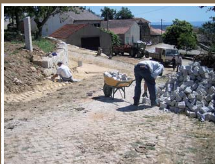
Alargamento e Pavimentação em CARVALHO
