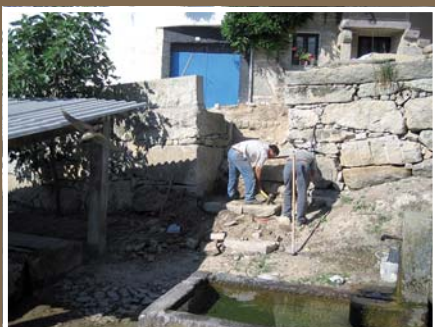
Construção de escadas em NOGUEIRA
