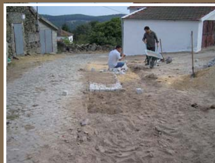
Pavimentação em VILARINHO DA MÓ
