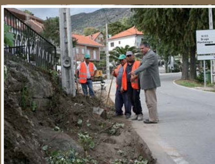
Regularização de valetas em SAPIÃOS
