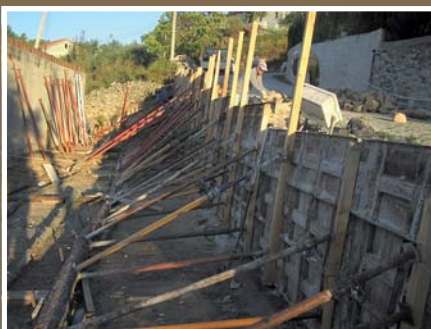
Construção de muro de suporte
