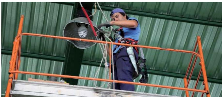
O Pavilhão Gimnodesportivo de Boticas foi alvo de uma intervenção que visou a substituição, por lâmpadas LED, das luminárias existentes no edifício.
