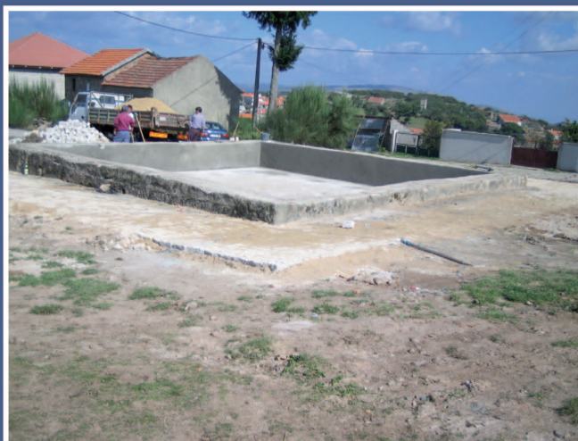
Pavimentação em Lavradas
