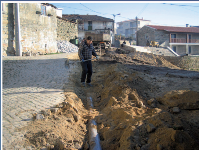
Repavimentação na Granja
