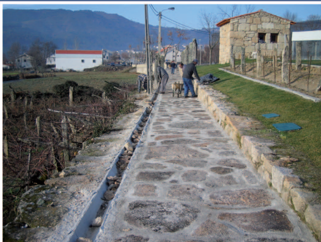
Pavimentação no Repositório do Vinho dos Mortos
