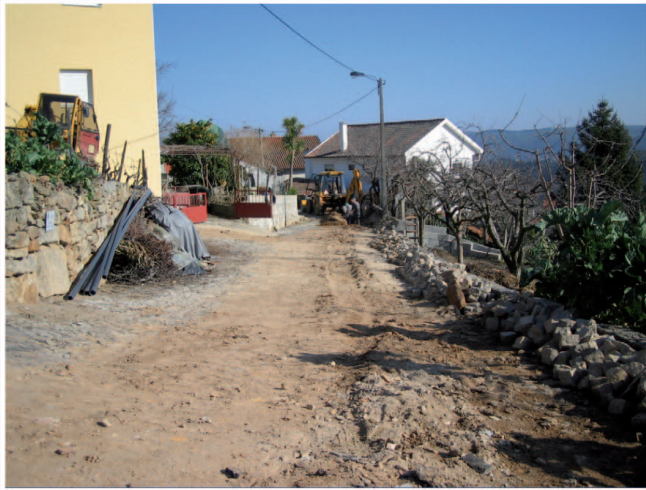
Renovação da rede de água no Bairro da Noruega
