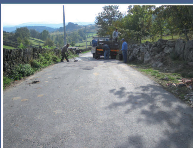
Repavimentação em Vilarinho Seco
