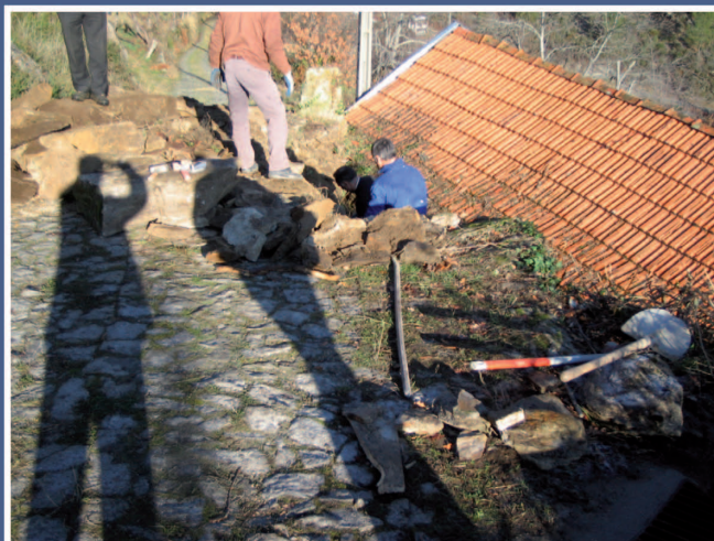
Reconstrução de muro de suporte em Casal
