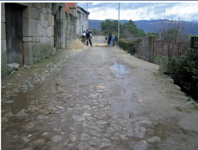
Repavimentação em Bobadela
