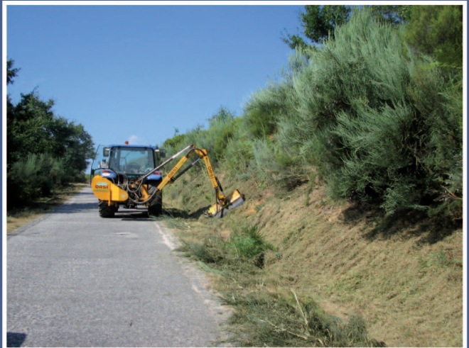
Limpeza de bermas na estrada de acesso a Carvalho
