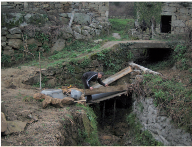
Obras de saneamento em Sobradelo
