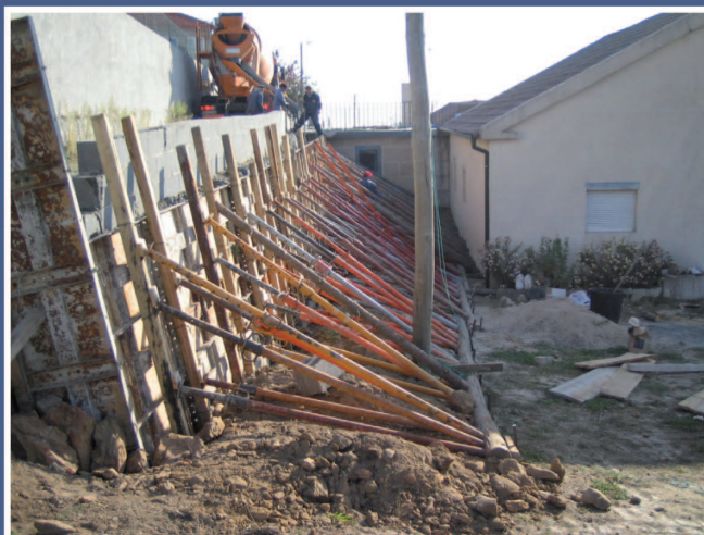
Muro de suporte em Lavradas
