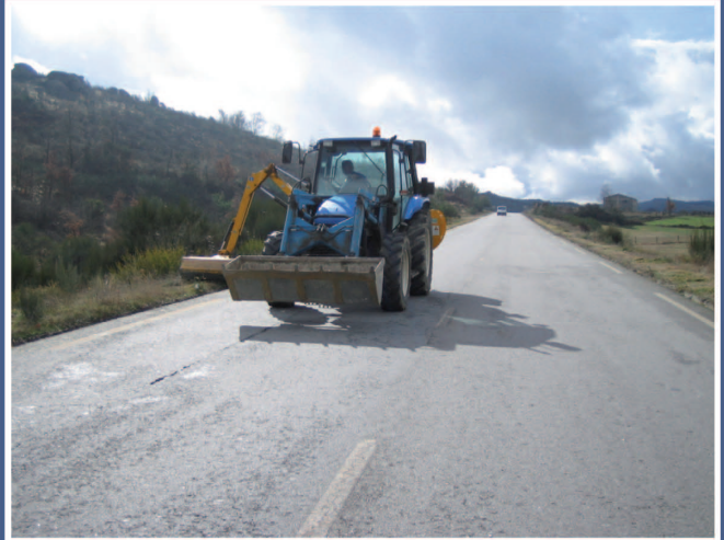
Limpeza de bermas na EM 312
