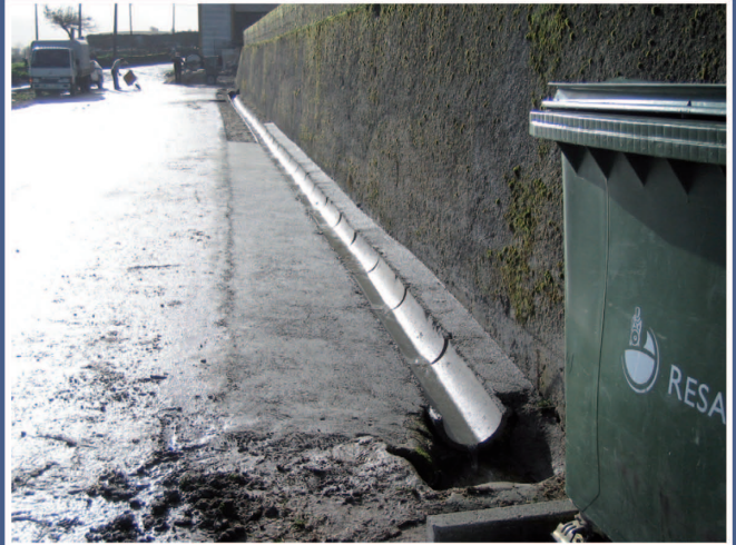
Construção de valetas em Viveiro
