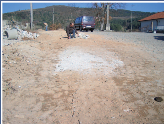
Repavimentação em Vila Pequena
