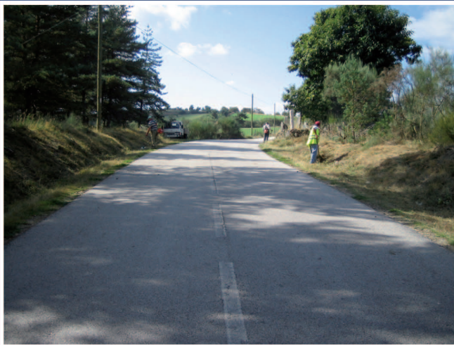
Limpeza de bermas na EM 520
