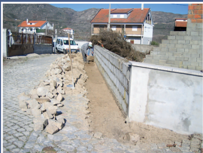
Repavimentação em Ardãos
