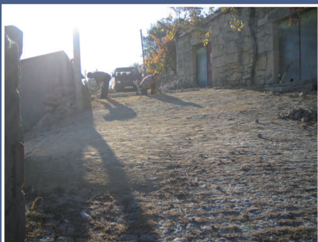
Repavimentação em Pinho
