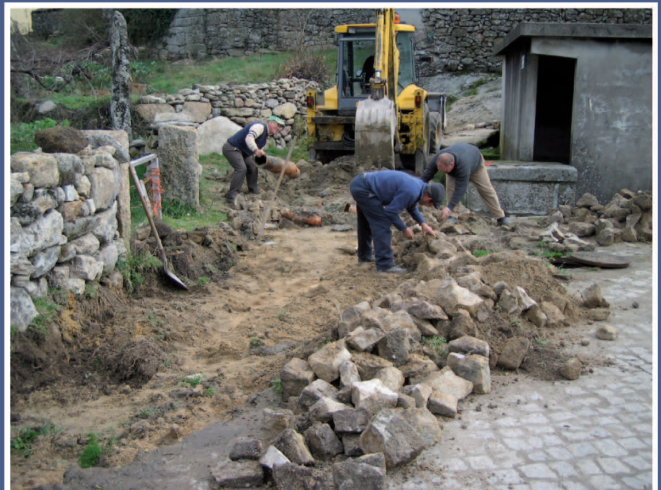
Pavimentação em Codessoso
