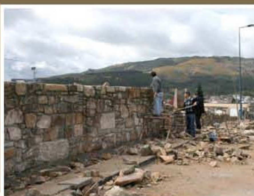
Construção de muro junto às Piscinas Municipais
