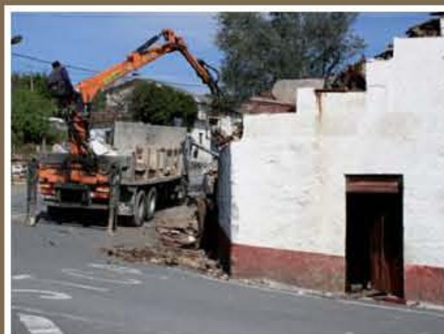
Demolição de casa na rua 5 de Outubro, Boticas
