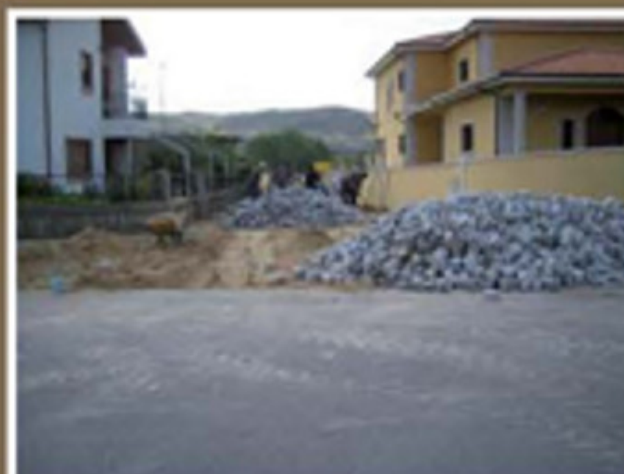
Pavimentação da ligação entre a Av. de Chaves e a Variante, em Boticas
