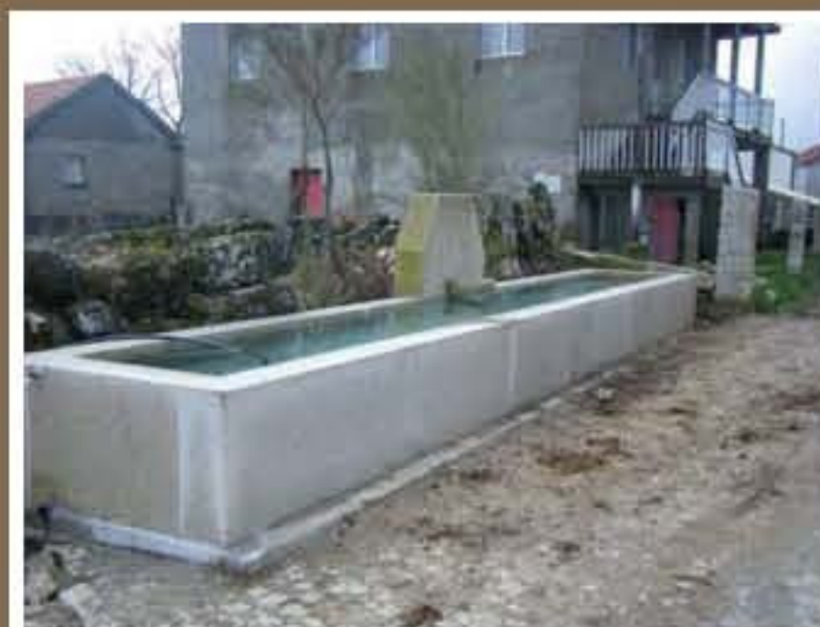
Construção de tanque e bebedouro para o gado em Alturas do Barroso
