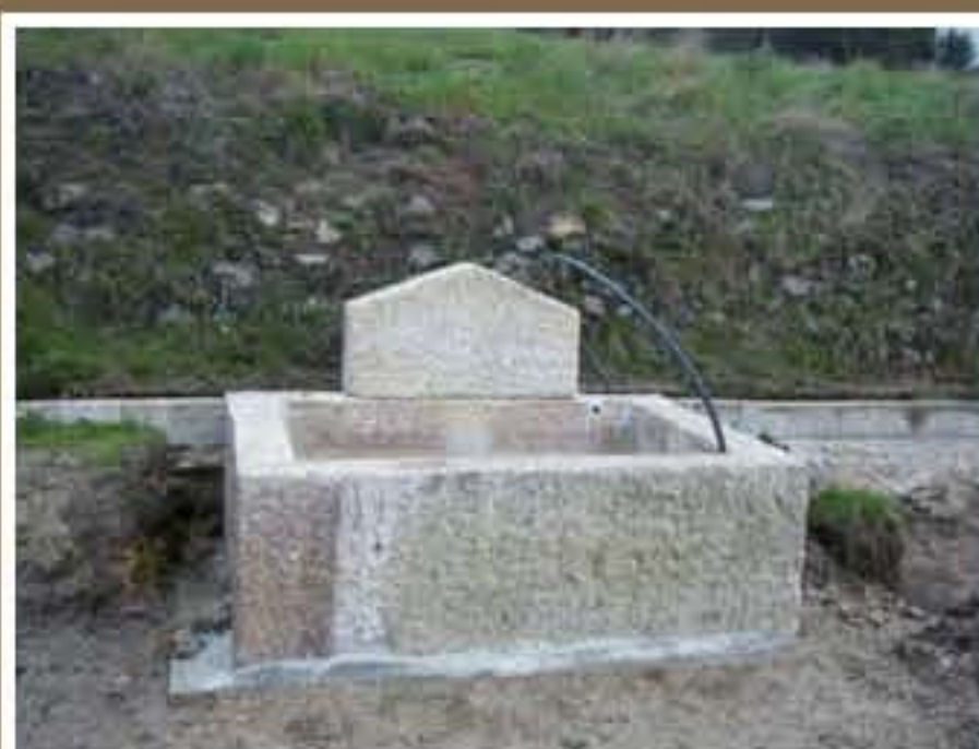
Construção de tanque em Alturas do Barroso
