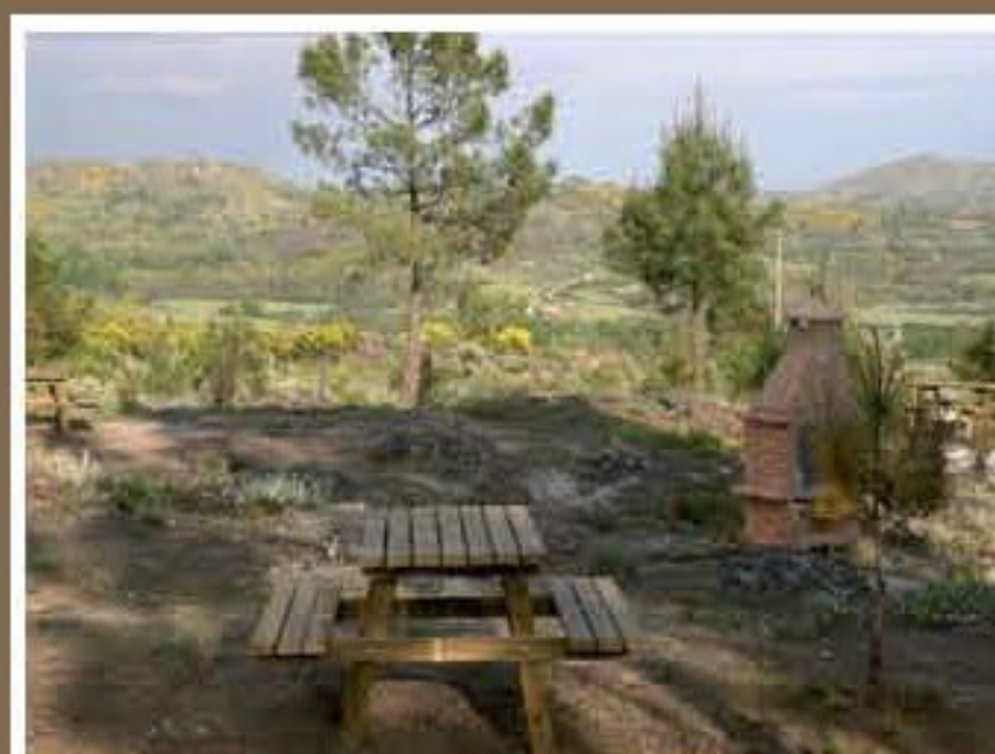
Construção de Parque de Merendas em Ardãos
