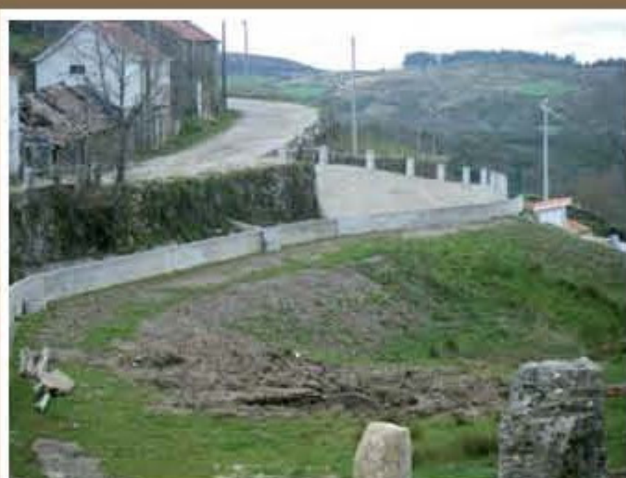
Construção do muro do "Rigueiro" em Alturas do Barroso
