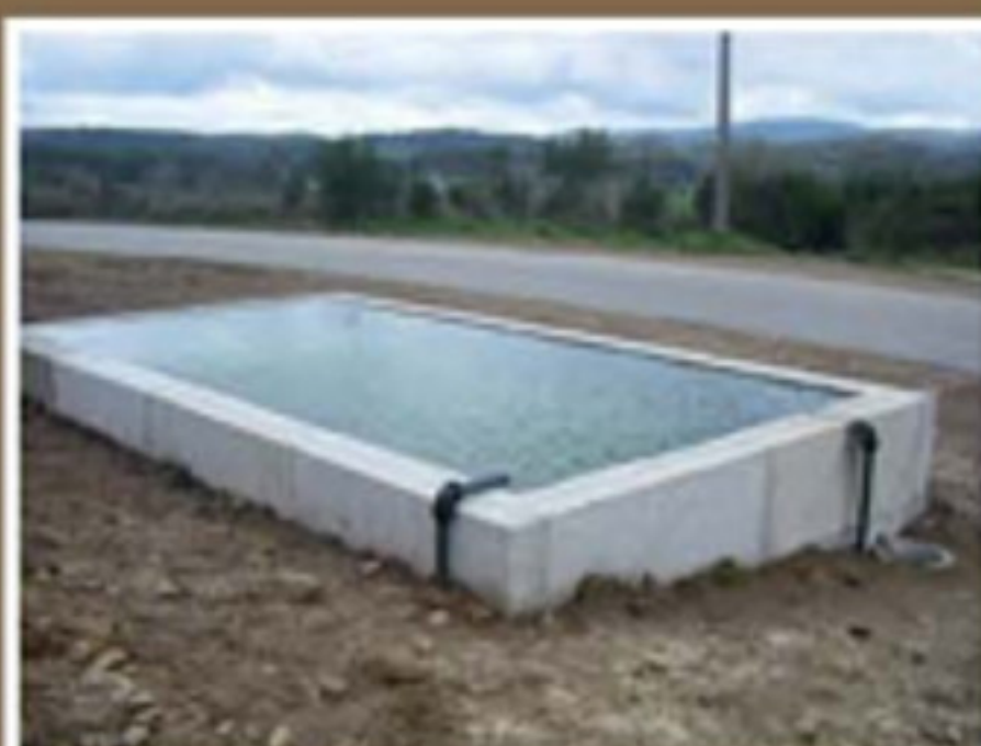
Construção de tanque de água em Lavradas
