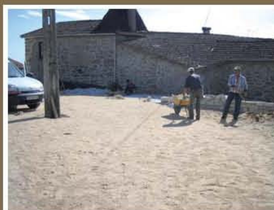
Pavimentação do Largo da Igreja, em Sapiãos
