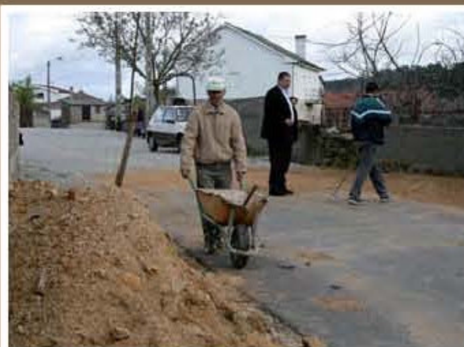
Pavimentação das bermas em Sapelos
