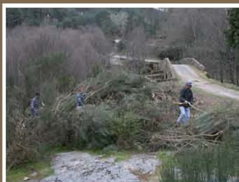
Limpeza de mato nas imediações da Ponte Pedrinha
