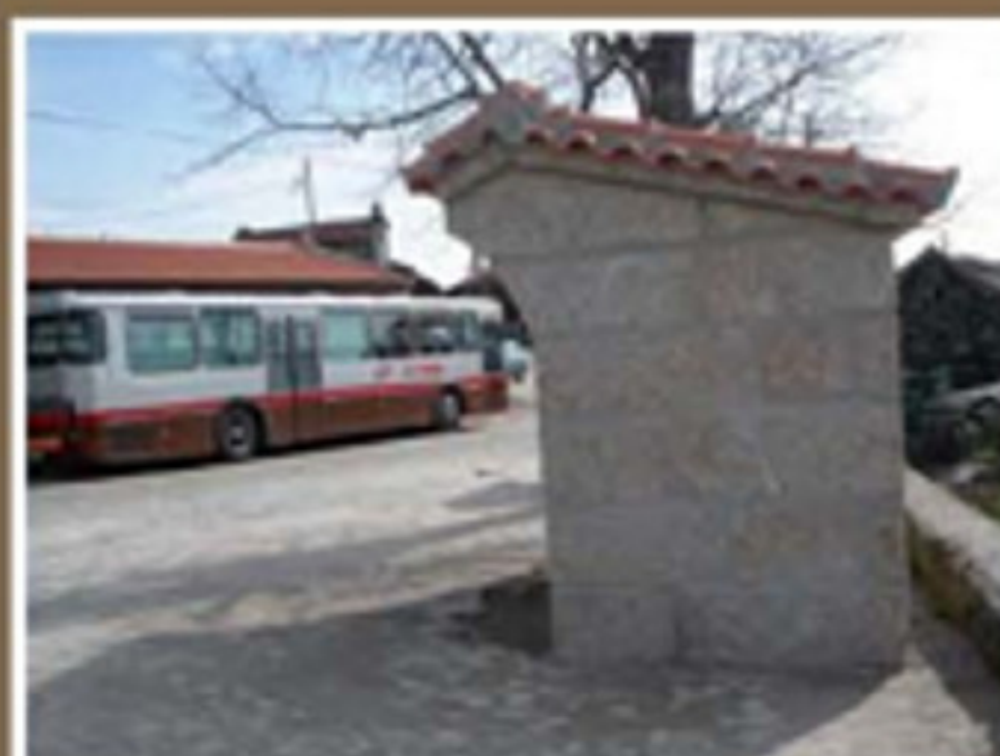
Construção de paragem do autocarro em Vilarinho Seco
