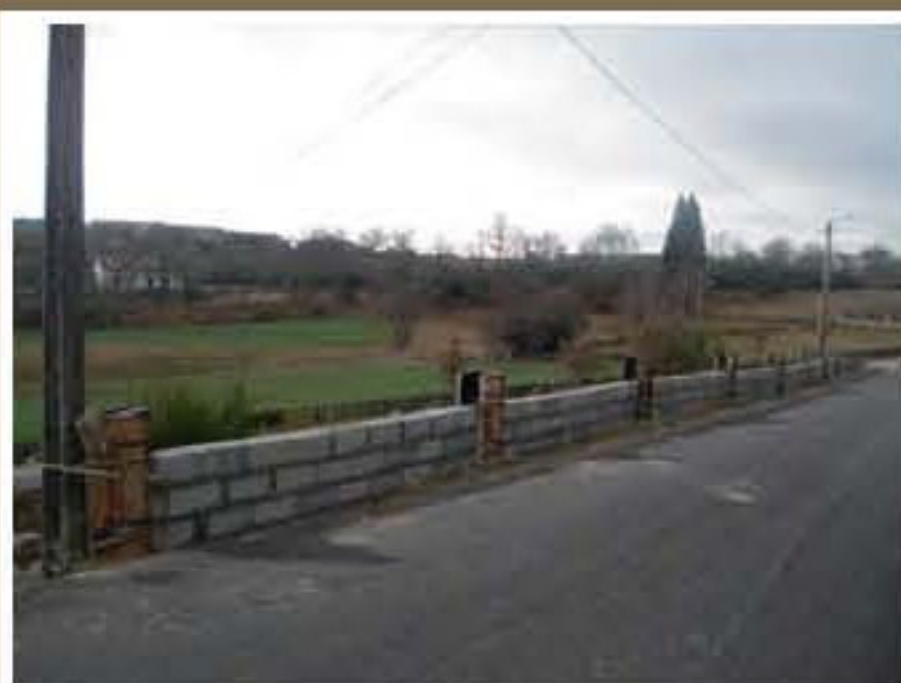
Construção de muro no Silvar, Atilhó
