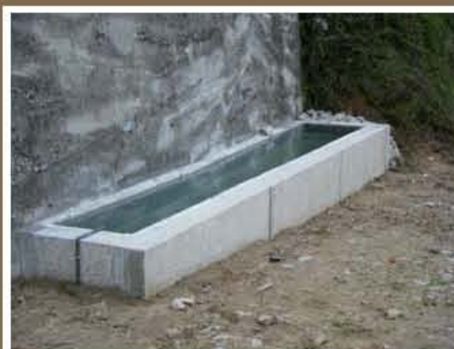
Construção de bebedouro para o gado em Lavradas
