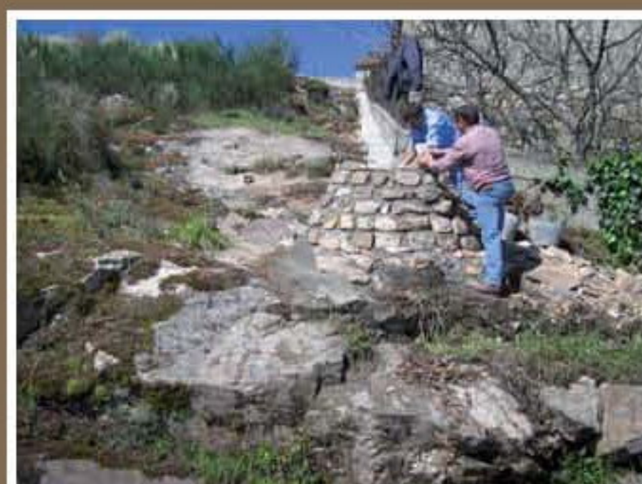
Prolongamento da rede de águas residuais em Sapiãos
