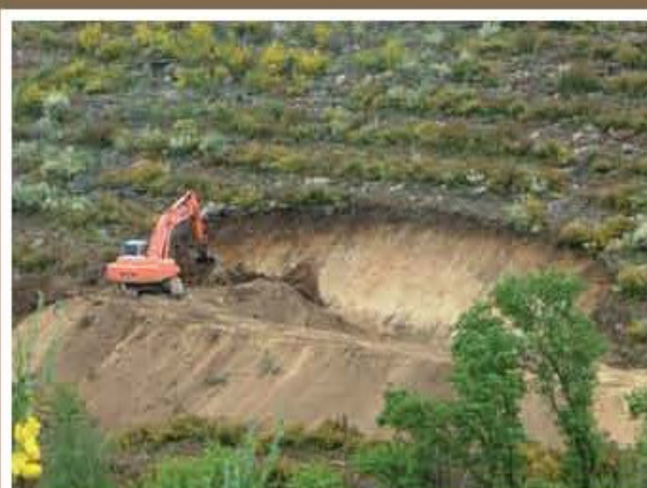
Construção de ponto de água na serra do Leiranco
