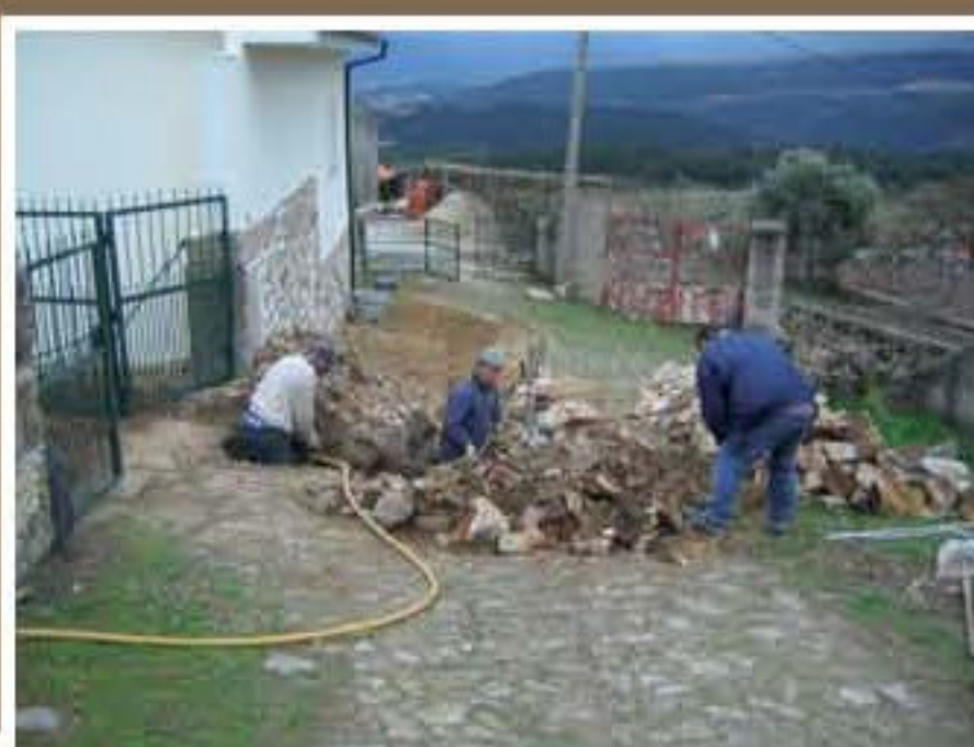
Ligação de saneamento em Pinho
