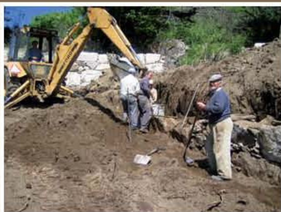
Beneficição e alargamento da "quelha" da Pássara, em Vilar
