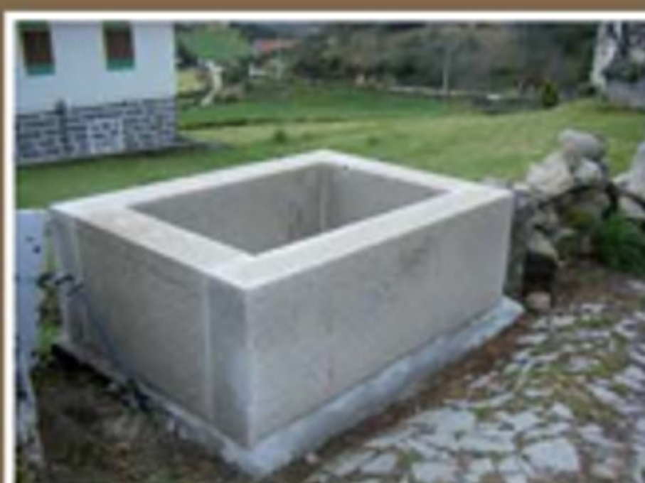
Construção de tanque em Alturas do Barroso
