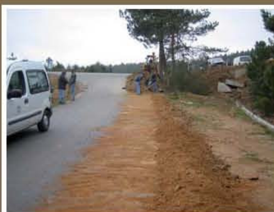
Prolongamento da rede de água em Carvalhelhos
