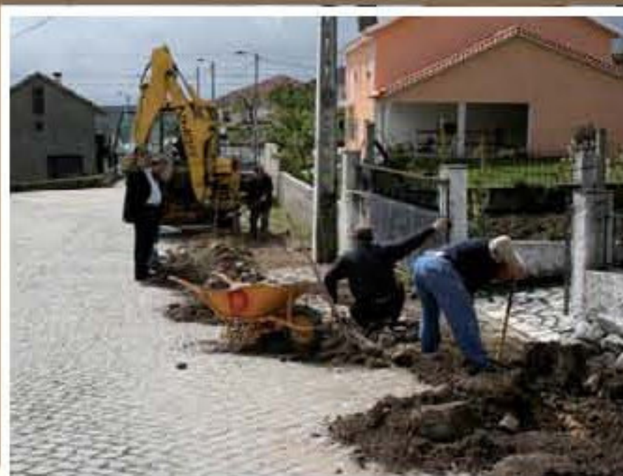
Ligação de águas pluviais em Sapiãos
